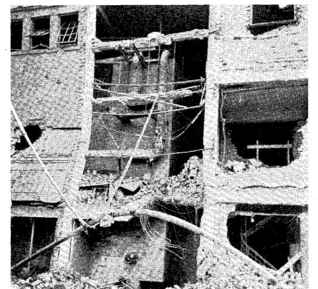
Fig. 2. Bomberamt jernbetonbygning. Aarhus.
